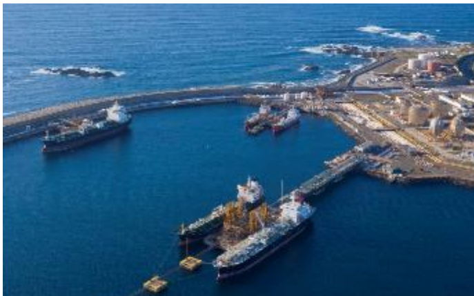
Terminal de Granéis Líquidos
